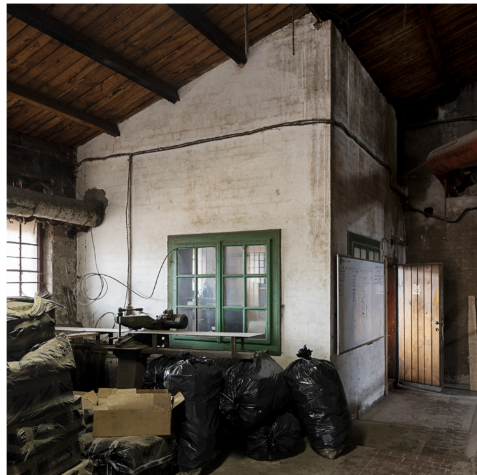
Kantorek w budynku klinkiarni.
