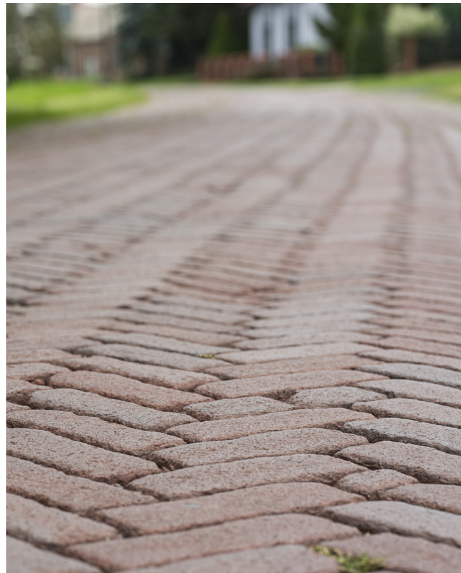
Droga klinkierowa w Sarnowie.
