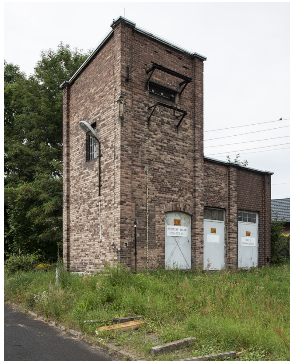
Stacja transformatorowa „Klinkierni Gródków”.
