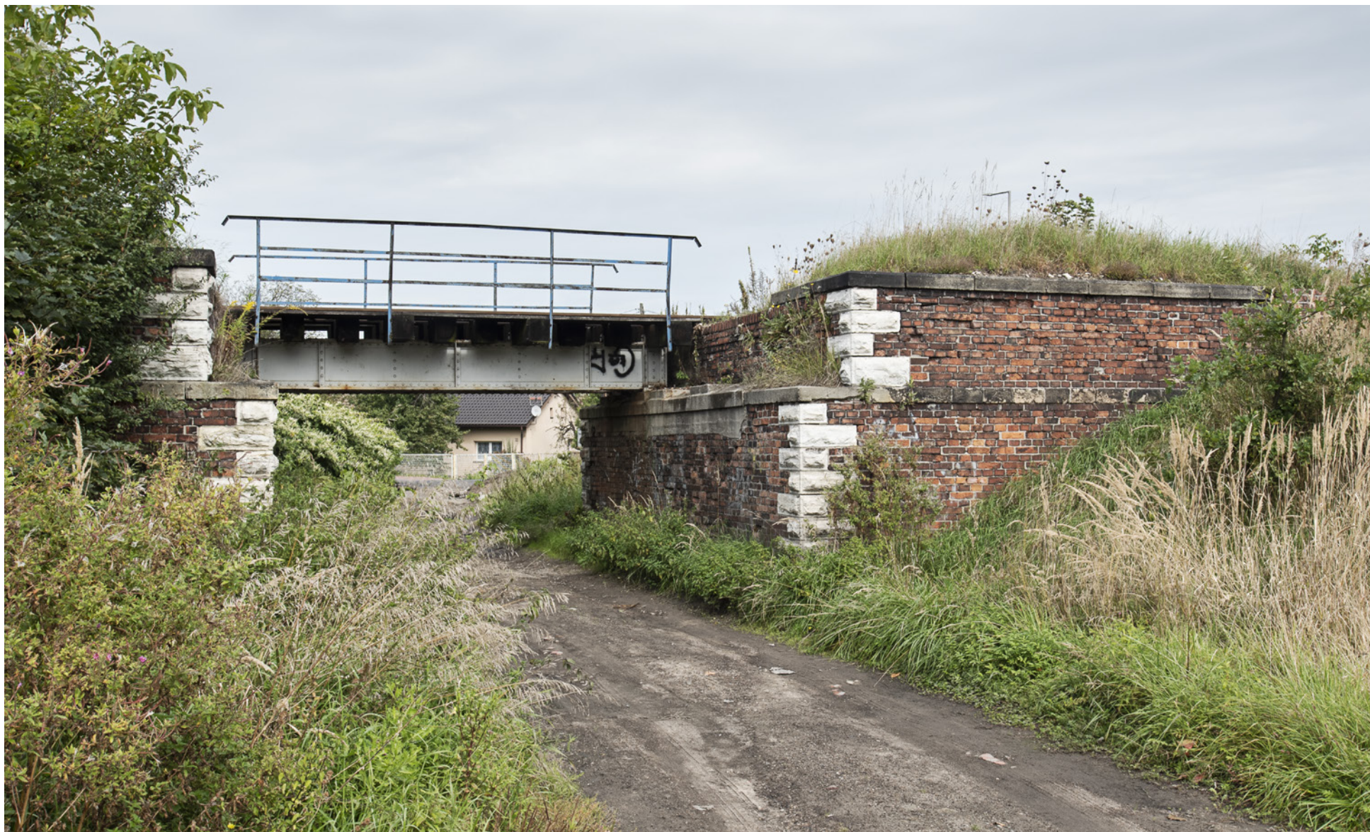
Przejazd kolejowy w Gródkowie.
